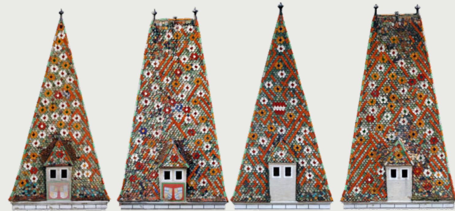
Oben, v.l.n.r.: Die teilrekonstruierte Westseite, Südseite, Ostseite und Nordseite des Turmdaches und dem Verlegeschema der Dachziegel.
