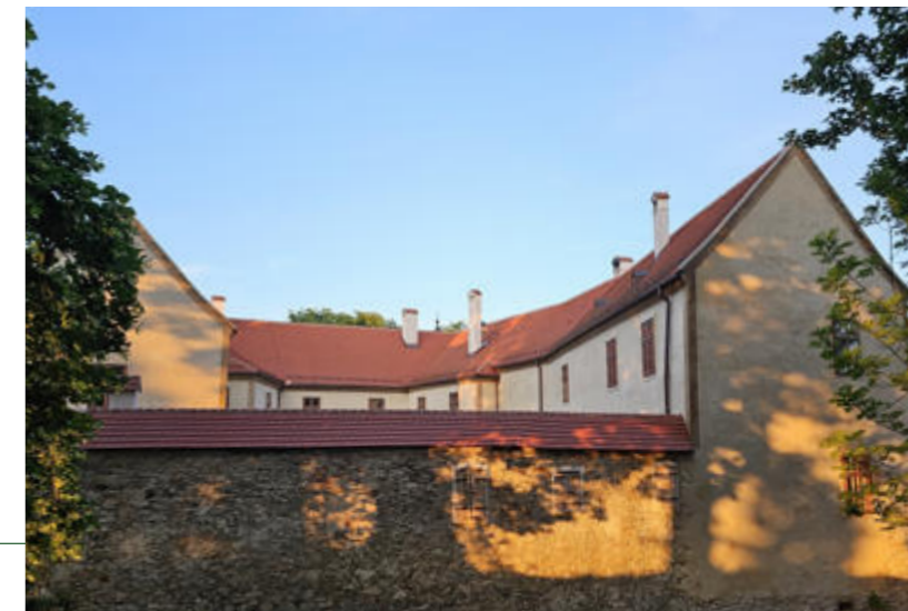
Oben: Schloss Lichtenau; Mitte und unten: Zustand während und nach der Restaurierung. Fotos © Emmerich Zöchbauer
